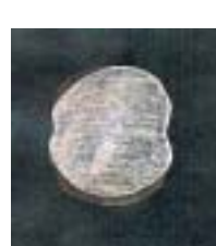
写真1 鉄筋断面形状
