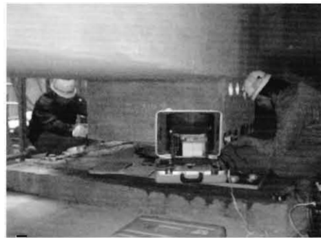
写真6 計測状況(2探触子法)
