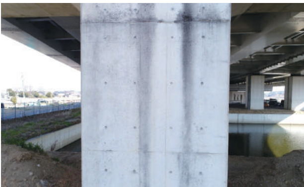
▲ドローン撮影画像（左から柱、配管）
